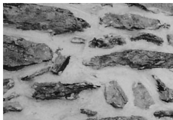
Structure à joints trop creux, interdite
